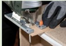
Das Holzstück wird von der Unterseite an der Führungsschiene entlang der Schnittlinie mit der Stichsäge zugesägt.
