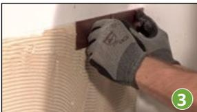
2. Mit einem 3 mm Zahnspatel bis zu max. 0,5 m<sup>2</sup> Montagekleber entlang der Markierung auftragen.
