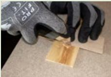
Die 2 mm Riemchen können an der Oberseite entlang der Führungsschiene mit dem Cutter geschnitten werden.
