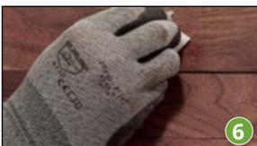
6. Klebereste in den Fugen vorsichtig mit dem Cutter und Klebereste auf den Holz-Riemchen mit Reinigungstüchern entfernen.
