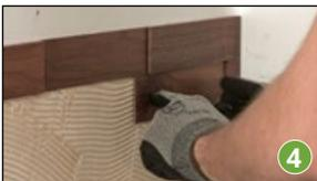
3. Entlang der oberen Markierung das erste Riemchen anlegen, ausrichten und in das frische Klebett drücken.
